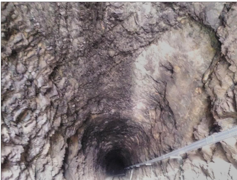
Obr. 16: Jílovský tunel – vystrojené jsou pouze příportálové úseky délky cca 10 m. Přes tuto skutečnost je nutné konstatovat, že masiv drobových břidlic je velmi rozpukaný. Patrné jsou tektonické zóny – viz schématický zakreslení linií, v daném místě – přibližně 30 m od portálu Luka pod Medníkem byly patrné úkapy z klenby, zřejmě dlouhodobé.
