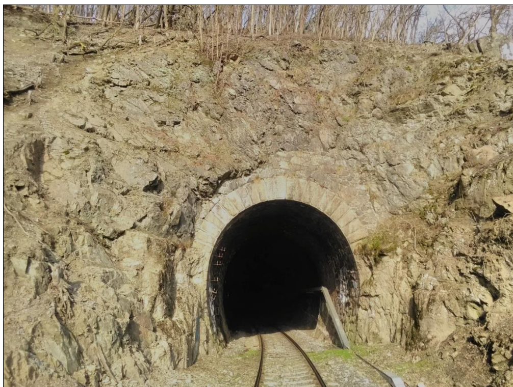
Obr. 13: Portál jílovského tunelu – strana u obce Luka pod Medníkem. Tunel je ražen v masivu drob. Nadloží tunelu činí rámcově 10 – 40 m. Nad konstrukcí tunelu se bude nalézat základ pilíře mostu přes Sázavu.
