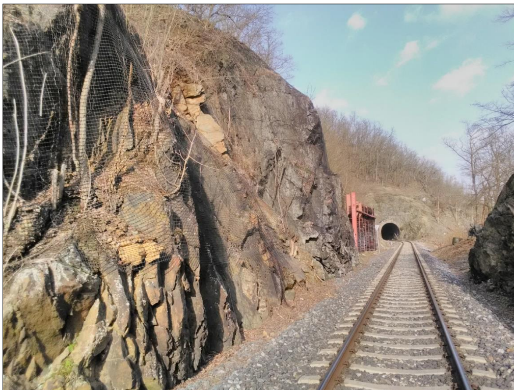
Obr. 12: Jílovský tunel (pohled na portál na straně Luk pod Medníkem) a skalní zářez. Masiv drob až spilitů efuzivního vulkanismu jílovského pásma českého proterozoika.
