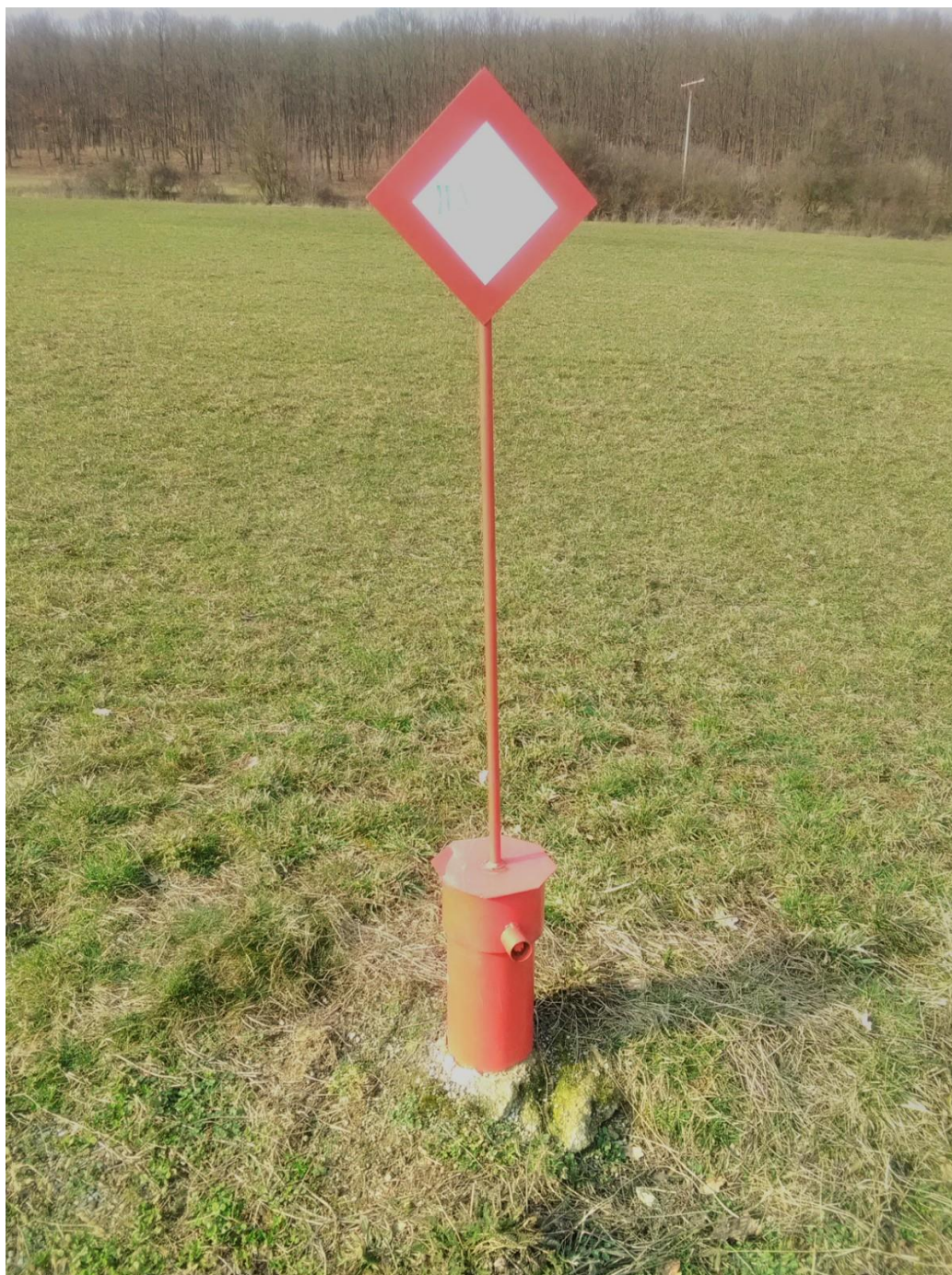
Obr. 4: Vrt u budoucího tunelu.
