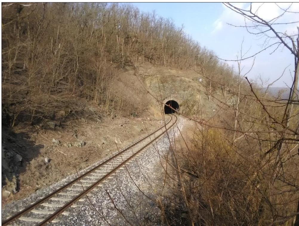
Obr. 14: Celkový pohled na Jílovský tunel II.
